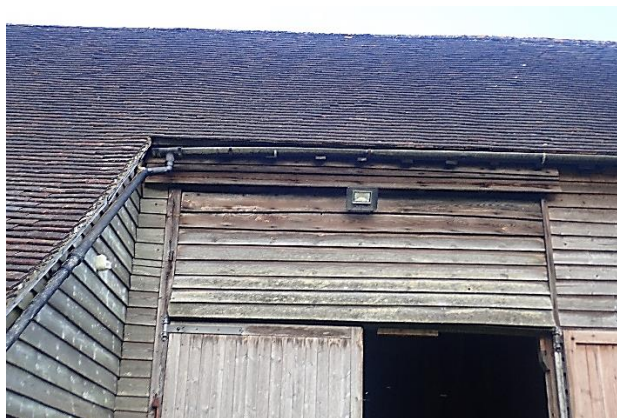
Fig. 5 – main barn doors, W side
