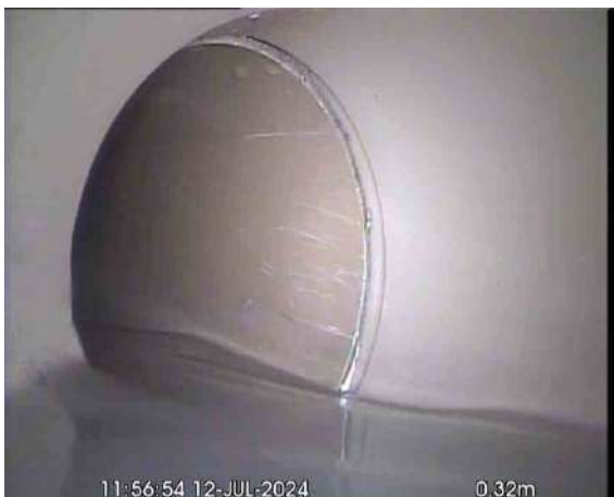
MH2X_e093e4d7-d568-40a8-a048-f18372491e2a_20240725_092700_602.jpg, 00:00:58, 0.32 m Line deviates left
