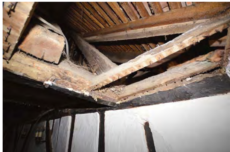
Ceiling Record (38).JPG
