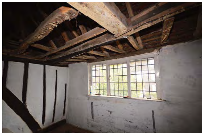
Ceiling Record (18).JPG
