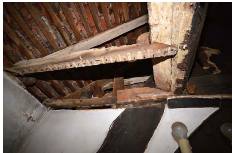
Ceiling Record (20).JPG
