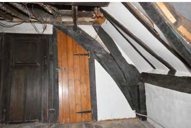
Ceiling Record (47).JPG
