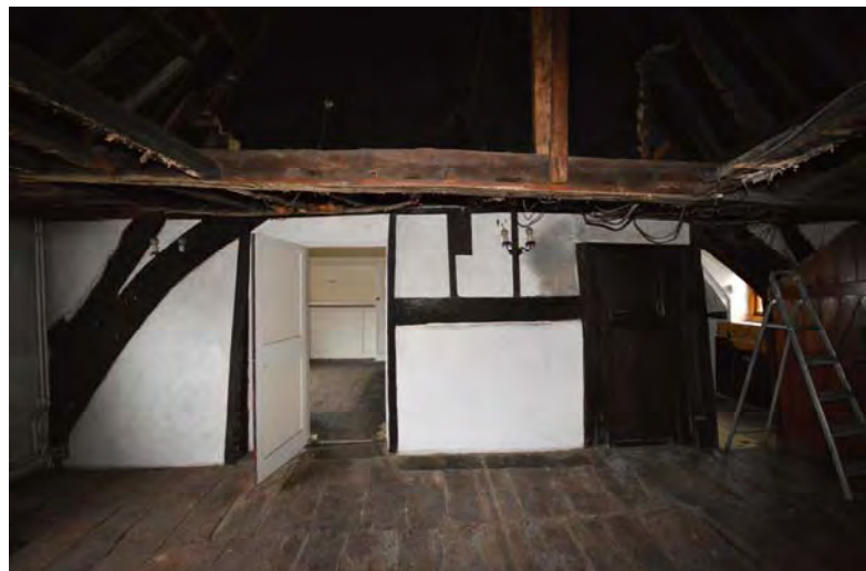
Ceiling Record (26).JPG
