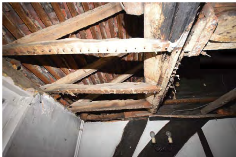
Ceiling Record (30).JPG
