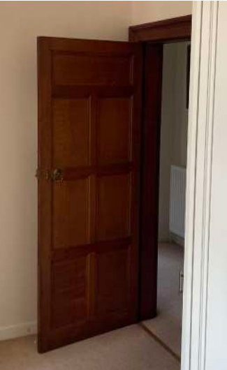
Existing Door D1
