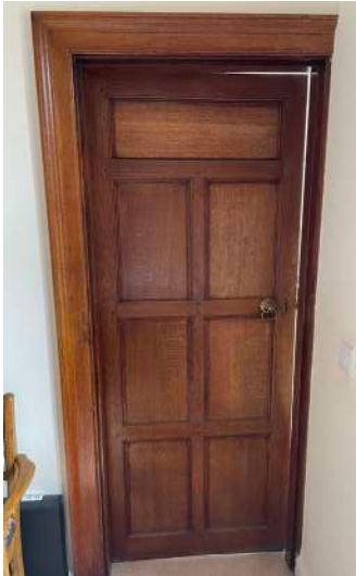
Existing Door D2
